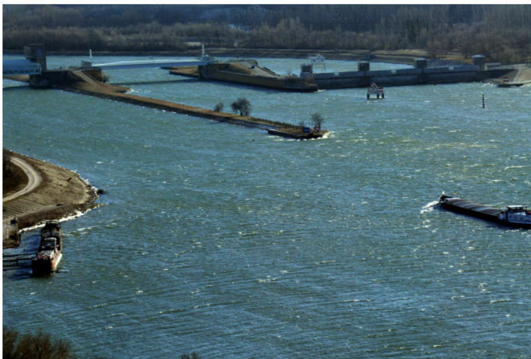
Barrages vue generale T 1733
